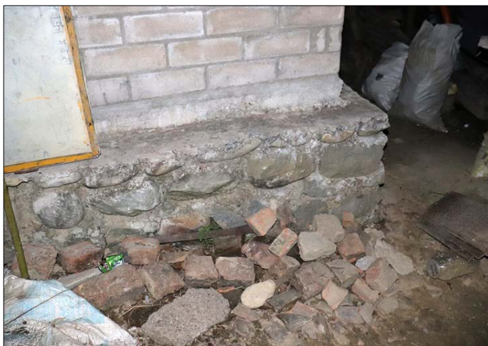
På ett av de färdiga husen kan man se hur grunden har höjts för att förhindra översvämning.
